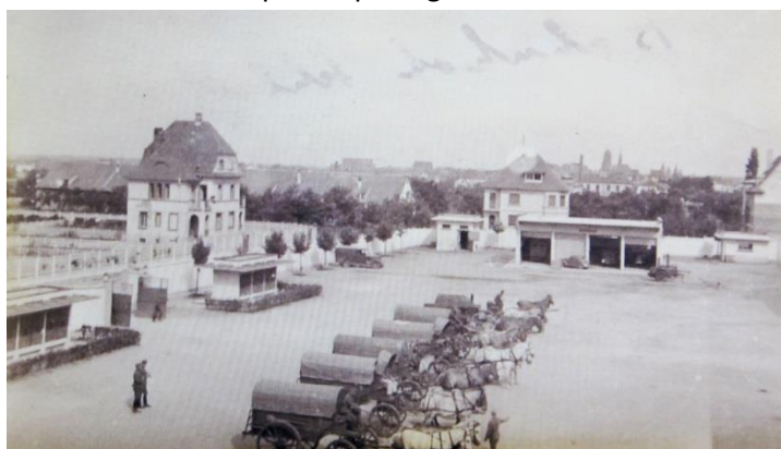
La caserne durant l'occupation allemande On distingue à gauche, les soutes à munitions, de part et d'autre du portail donnant accès à la Frankembourg Strasse
