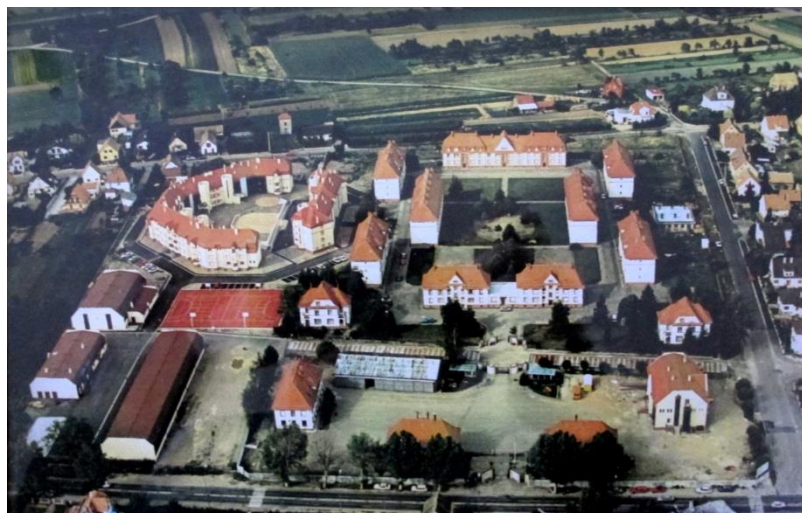
Le quartier Cambours en cours de restructuration, fin des années 1980
