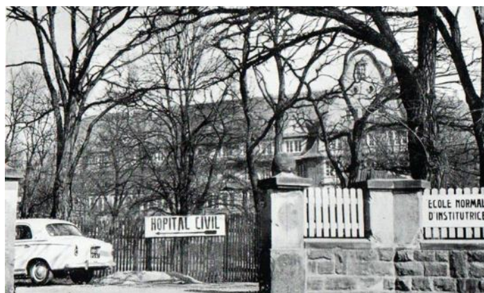
École Normale d'institutrices ET Hôpital civil Photo prise vers 1960 depuis la rue August Froehlich (1) , supprimée en 2017 (1) Prêtre catholique allemand, adversaire du national-socialisme, assassiné par les nazis à Dachau en 1942
