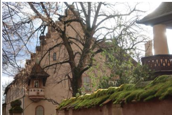
L'un des bâtiments de la Lieutenance, avec ses pignons crénelés
