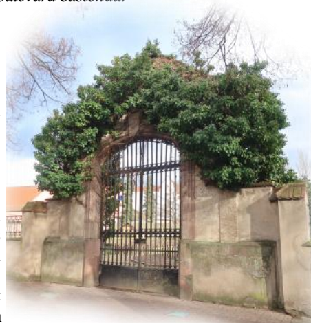
Le portail sur le bld Castelnau en janvier 2023 Les piliers et la voute ont été changés après guerre
