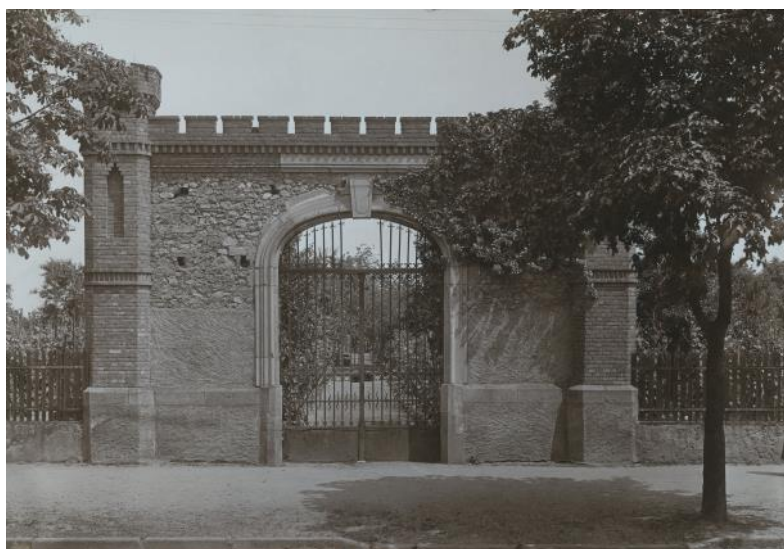
Entre 1932 et 1939 - Le portail d'entrée du jardin de la Lieutenance, sur le bld Castelnau Source : Archives municipales de Sélestat
